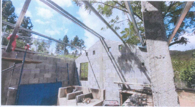
Foto 1: Instalación de techo pórtico.
