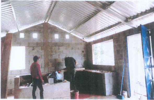
Foto 3: Instalación de banco de trabajo.
