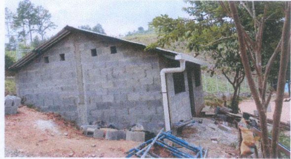
Foto 2: Instalación de bajada de agua pluvial.
